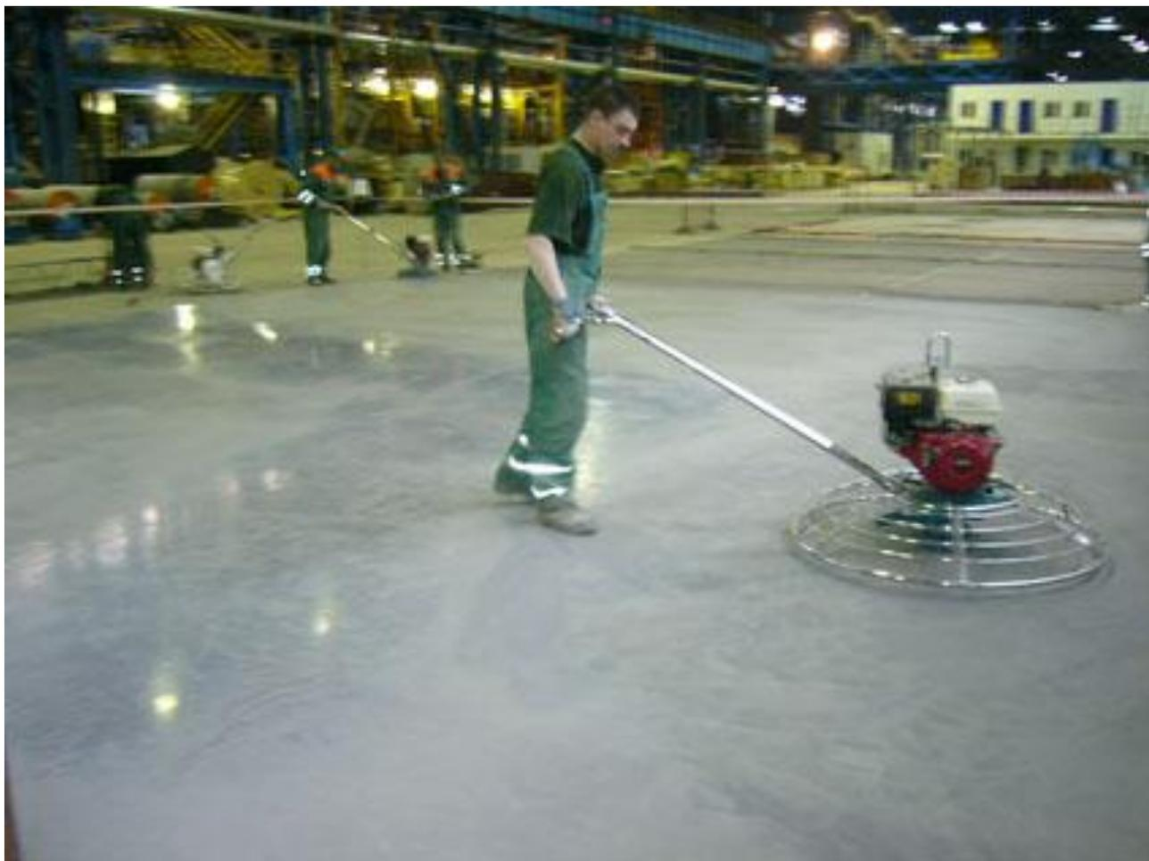
4.5.9 Внешний вид: Признаком окончания выглаживания служит образование ровной гладкой «зеркальной» или полуматовой поверхности. Не рекомендуется допускать «пережигания» поверхности лопастями, особенно при выглаживании цветных вариантов покрытия MasterTop® Dry-Shake.
