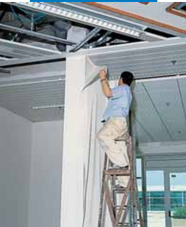
Приклеивание настенного покрытия в офисном здании
