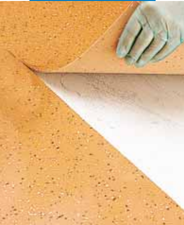
Укладка ПВХ-покрытий при помощи Adesilex G20
