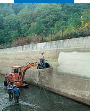
Нанесение Planiseal 88 напылением на подводный канал гидроэлектростанции
