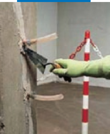
Фиксация инъекционных трубок с помощью Adesilex PG1
