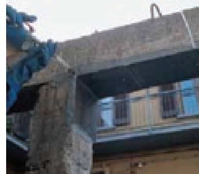
Ремонт балки с инъектирование Epojet
