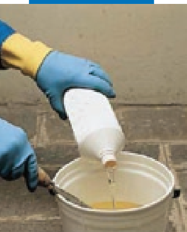
Замешивание Epojet
