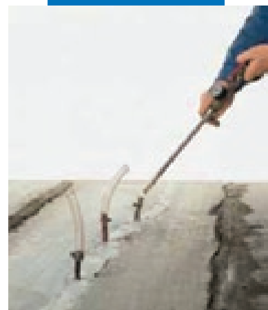
Восстановление горизонтальной конструкции с инъектирование Epojet
