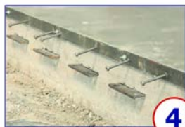
4. После заливки демонтируйте деревянный брус и установите закладные
